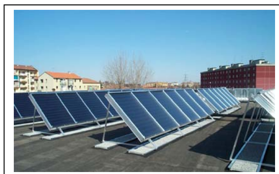
Schema termico su tetto condominiale
